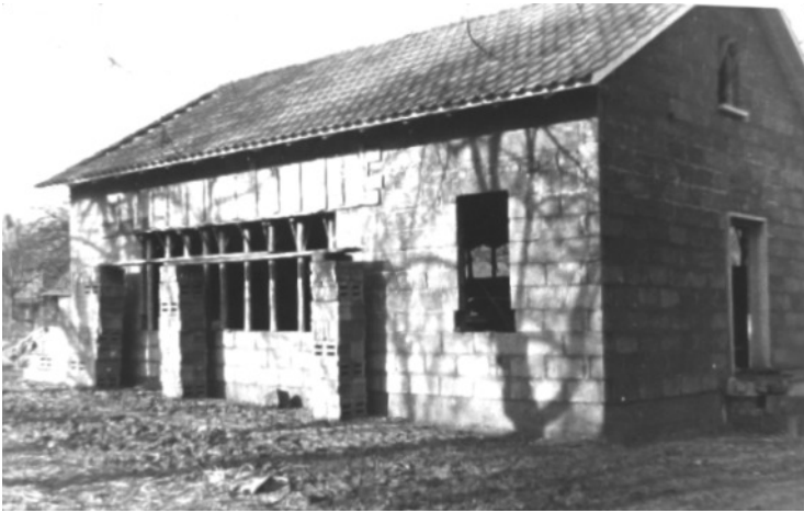
Kapelle im Rohbau
